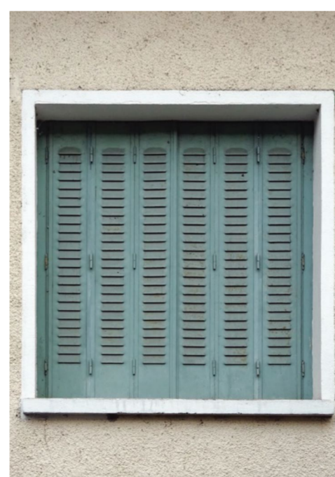
Encadrement en creux enduit lisse
